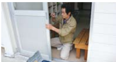
施設・設備の修繕
